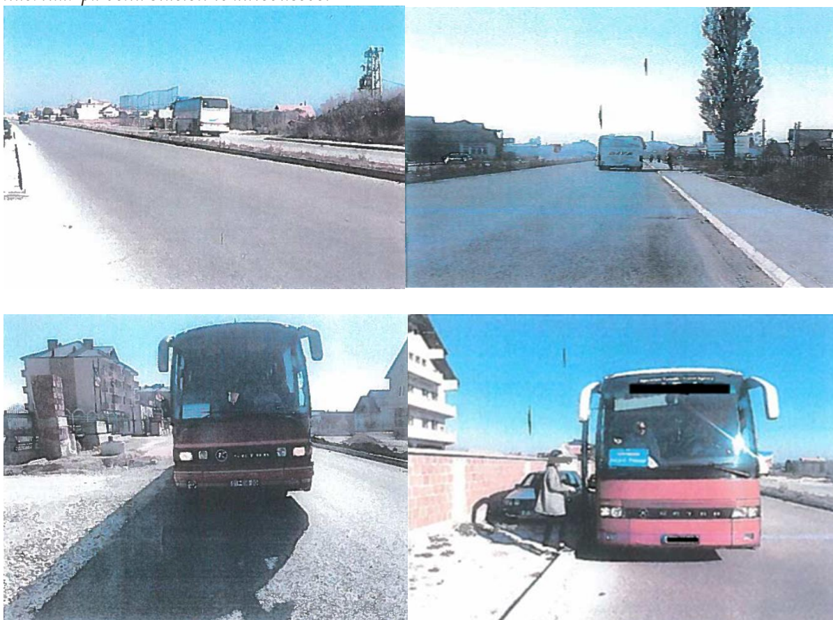
Foto 2. Ndalesa e autobusëve në rrugën Nationale N25, segmenti rreth rrotullimi Besi – Podujevë e ndërtuar pa vend stacion të autobusëve. 29
