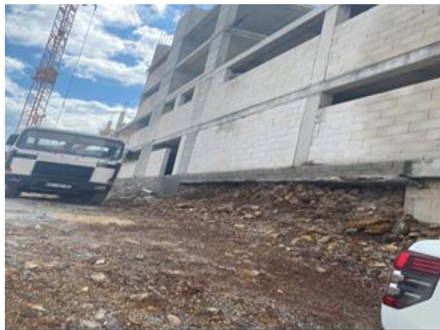
Slika 4. Snažna konstrukcija u ugovoru o zakupu (slika inspektorata)
