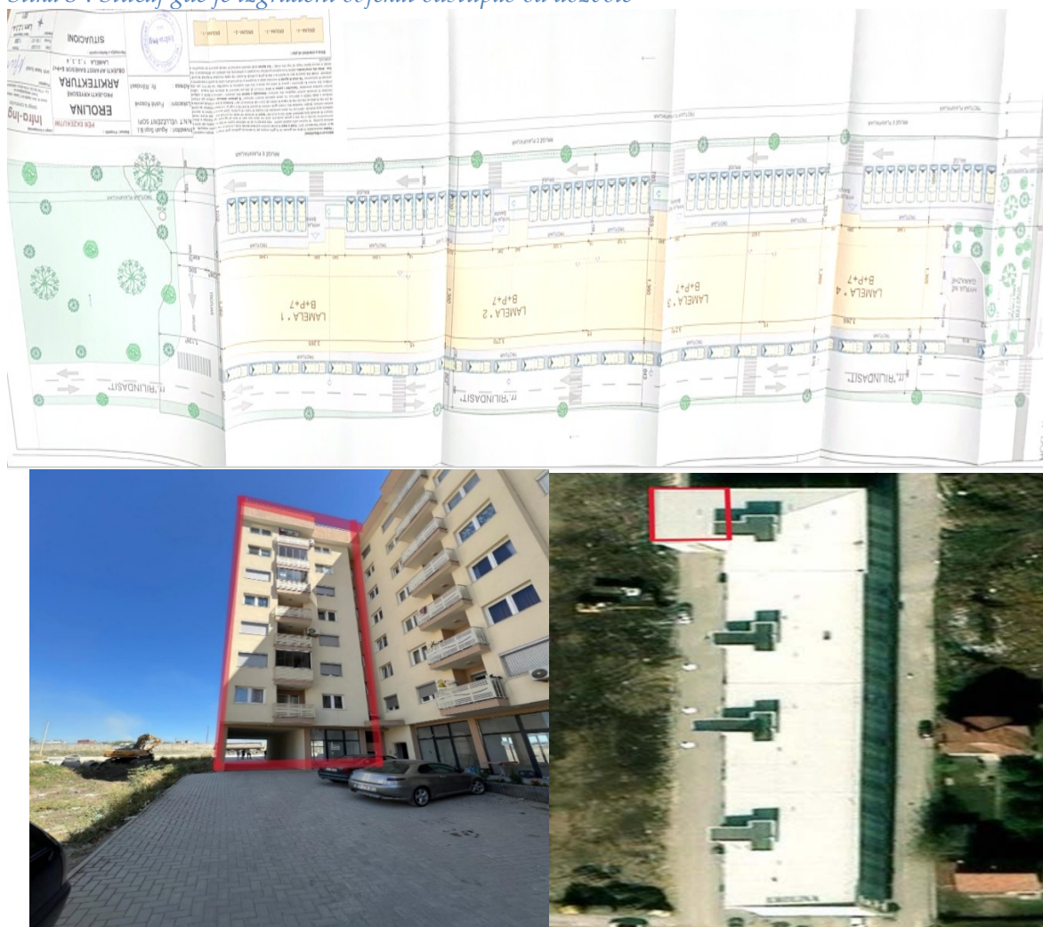
Slika 5 : Slučaj gde je izgrađeni objekat odstupao od dozvole
