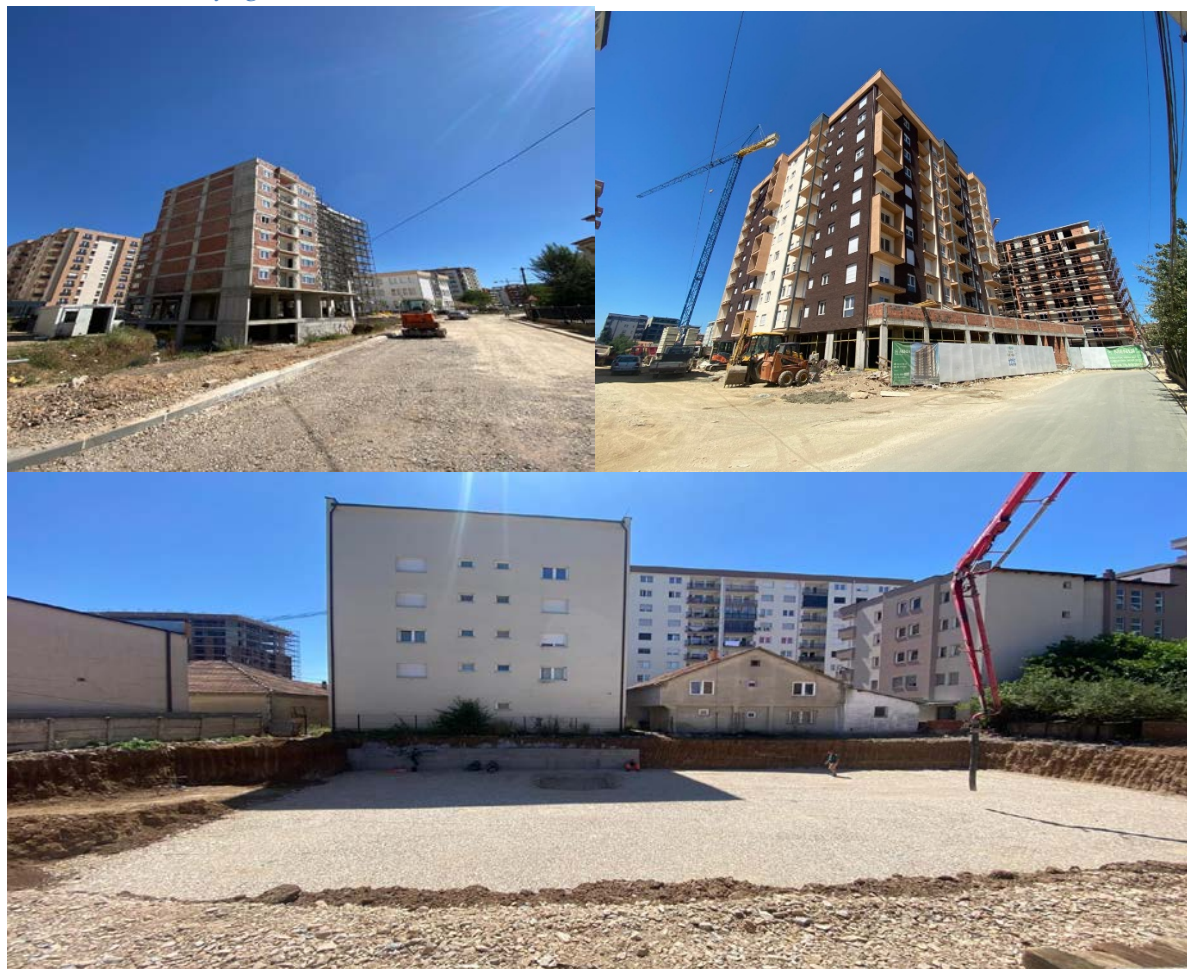
Slika 4: Slike stanja gradilišta
