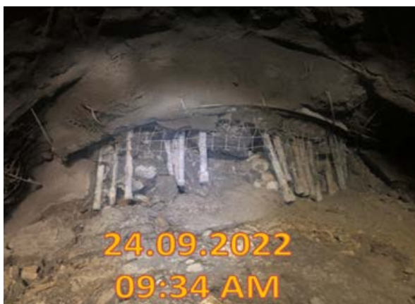
Slika 4. Urušavanje Tunela 6 – fotografija od nadzornog organa
