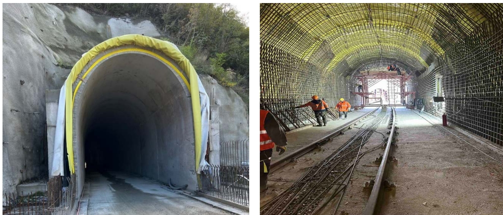
Slika 2. Pogled sa fizikalnog pregleda sanacije Tunela 6 i 7
