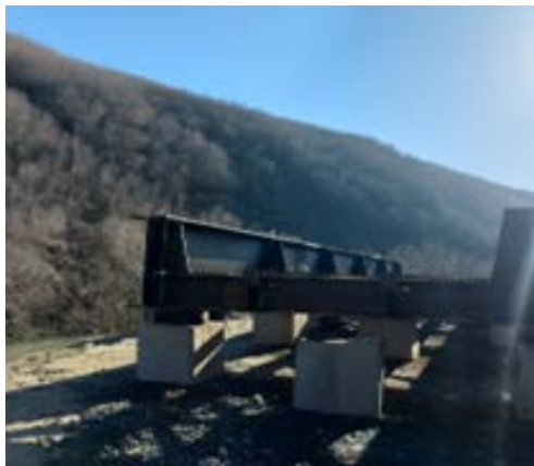
Slika 6. Metalni mostovi isporučeni ne montirani
