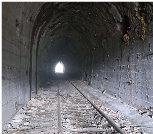
Slika 3. Slike sa fizičke provere tunela br. 2, 3 i 5
