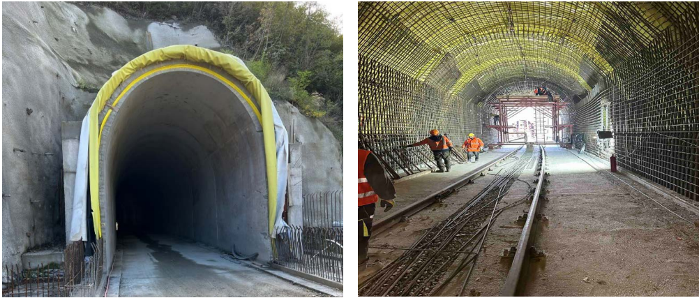
Foto 2. Pamje nga ekzaminimi fizik i rehabilitimit të Tunelit 6 dhe 7
